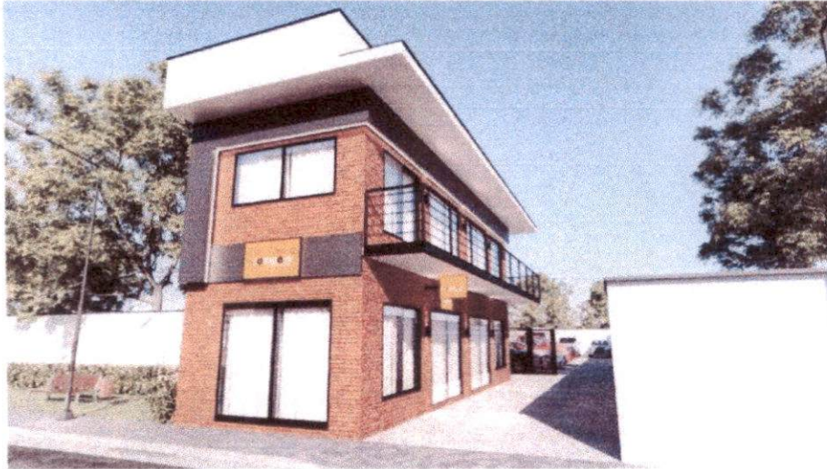
Imagem 01 - Perspectiva da fachada lateral/frontal da sede comercial.
